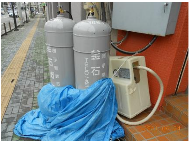
ガス発生装置により都市ガスの飲食店へ供給。
